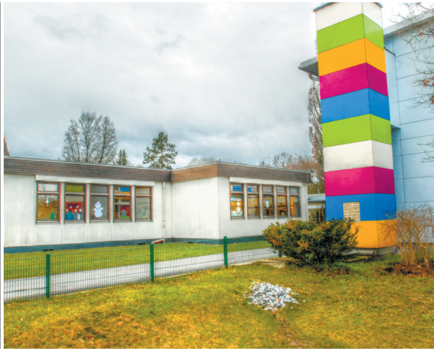
Bunt ist Trumpf: Teile der Michaelschule in Liemke sind bereits modernisiert. Demnächst werden die Pavillons (links im Bild) abgerissen und durch ein zweigeschossiges Gebäude ersetzt.
